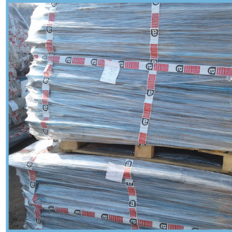
Abfall: asbesthaltige Baustoffe Schlüsselnummer: 17 06 05*
