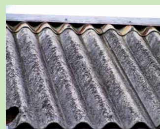
Asbestzement („Eternit“): Dacheindeckungen und Außenwandverkleidungen Quelle: Wikipedia
